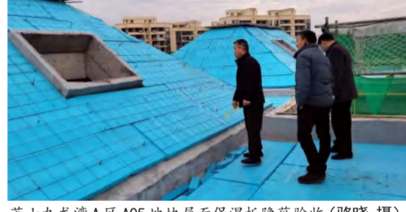
英山九龙湾A区A05地块屋面保温板隐蔽验收（骆晓 摄）
