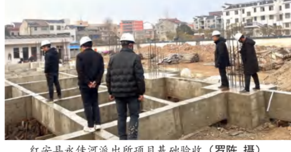
红安县永佳河派出所项目基础验收（罗陈 摄）
