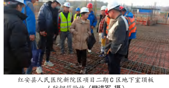
红安县人民医院新院区项目二期C区地下室顶板人防钢筋验收（樊进军 摄）
